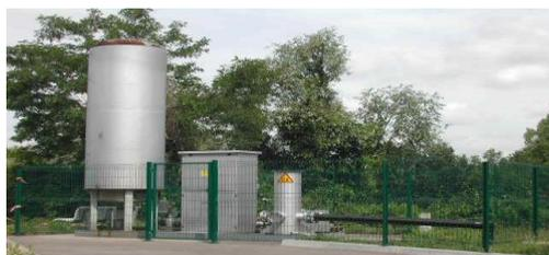
Les biogaz produits par les casiers exploités jusqu'en août 2006 sont collectés par un réseau de 24 puits et incinérés.
