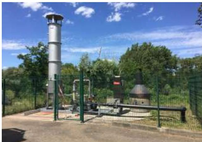
Les biogaz produits par les casiers exploités jusqu'en août 2006 et 2 puits du casier 3 sont collectés par un réseau de 20 puits mis en dépression, et dirigés vers une centrale de combustion installée à l'entrée du site. Cette torchère transforme le méthane du biogaz en gaz carbonique, dont l'effet de serre est 21 fois moins important, et casse les mercaptans responsables des odeurs.
