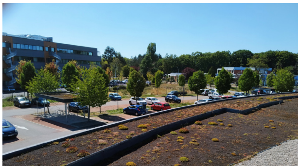
Centre technique de la Roannaise de l'eau
