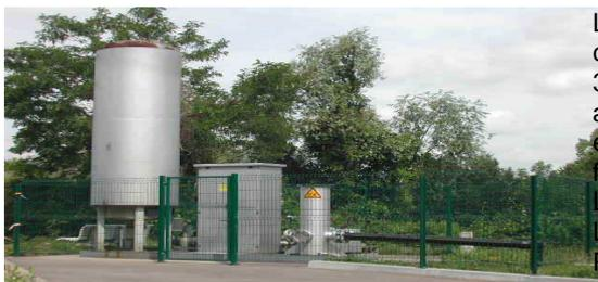
Les biogaz produits par les casiers exploités jusqu'en août 2006 sont collectés par un réseau de 20 puits et incinérés.
